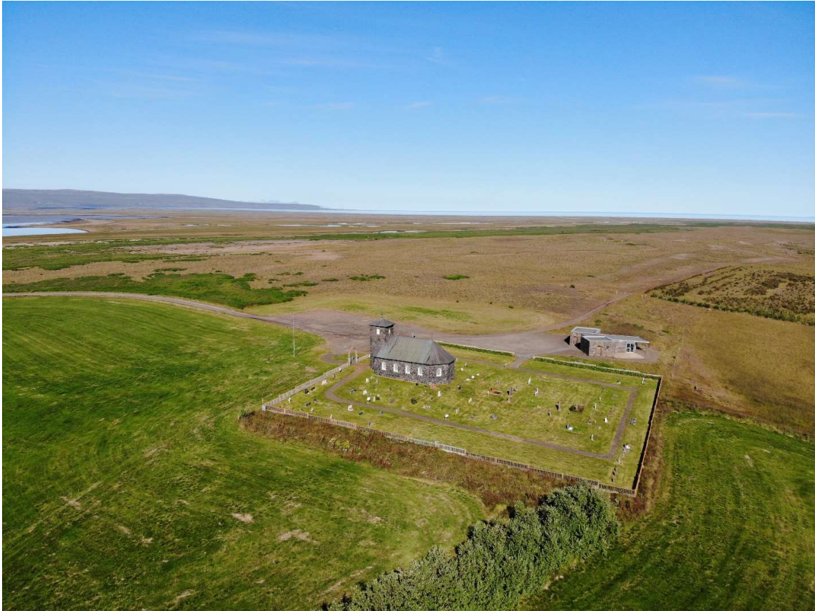
Mynd 1: Þingeyrakirkja, byggð 1877. Horft til norðurs.
